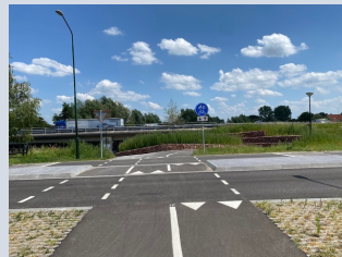
Impressie na aanleg onderdoorgang
